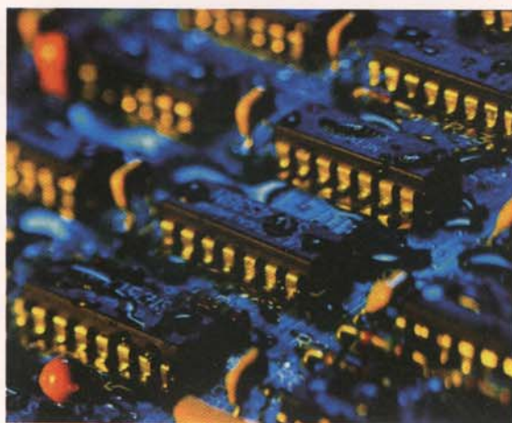
Bild 2. Die Feuchtigkeit nach der Reinigung muss entfernt werden
